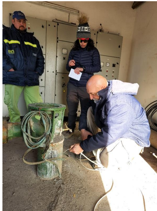
Ilustración 136 - Pozo 2 Prueba de recuperación
