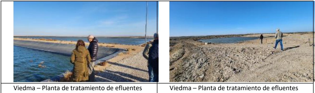
Ilustración 126 - Planta depuradora de Viedma
