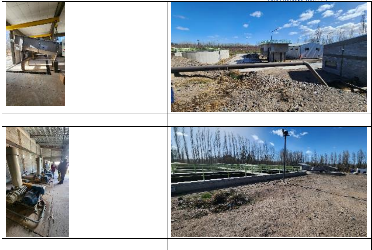
Ilustración 134 - Planta de Tratamiento de Aguas Residuales Cinco Saltos
