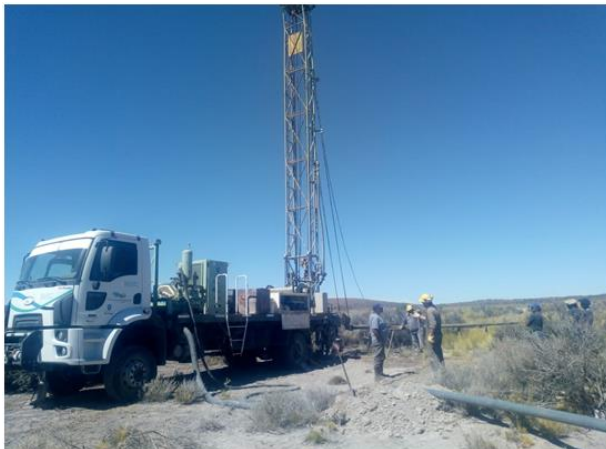
Máquina rotativa con inyección de lodos
