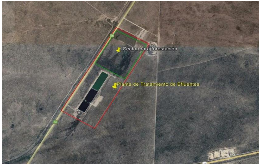
Ilustración 85 Sector dentro de la PTLC para uso del ART en riego forestal - Producción del Departamento de Bioingeniería
