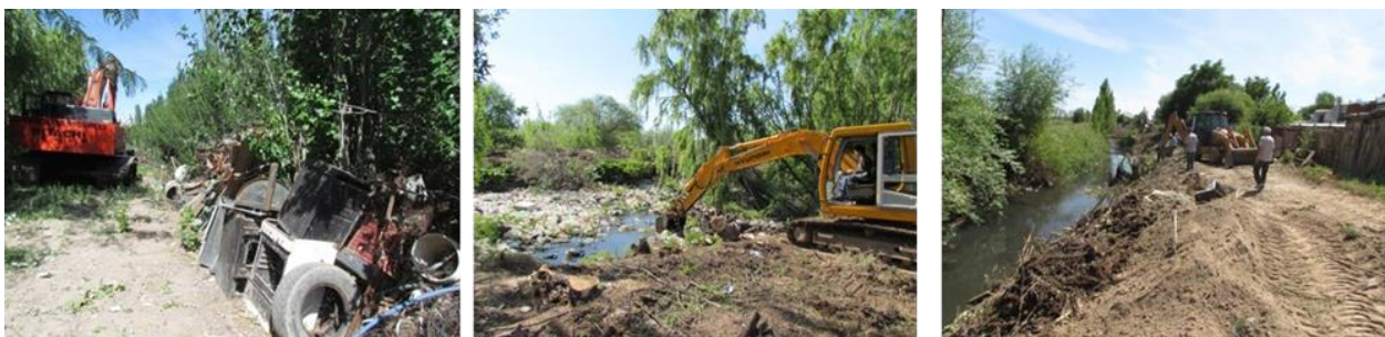
Ilustración 61 : Imágenes 14, 15 y 16: Residuos extraídos y maquinaria operando, residuos en el cauce y maquinaria operando y operarios y maquinaria de la Municipalidad de Cipolletti acondicionando banquinas, respectivamente.
