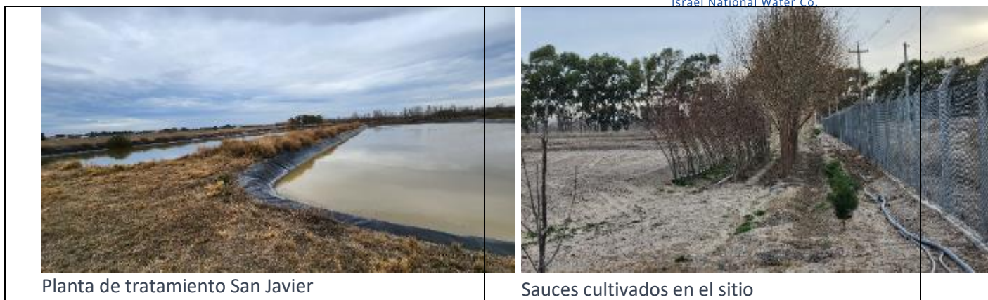
Ilustración 127 - Planta de tratamiento San Javier
