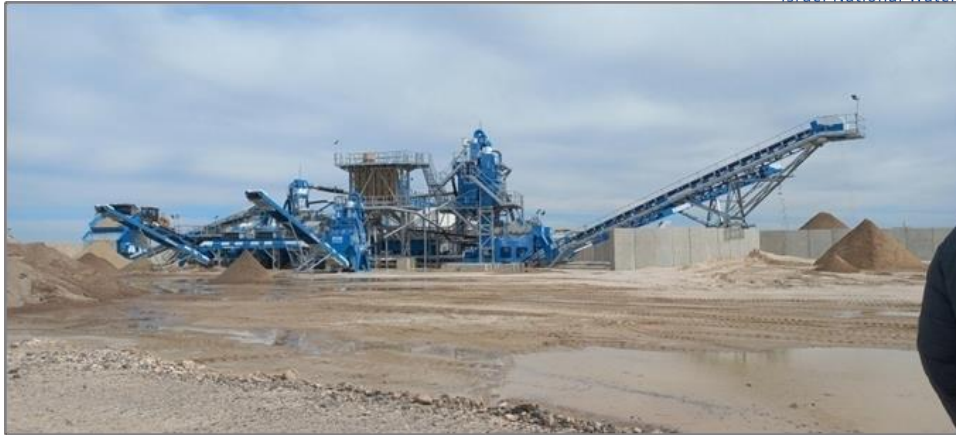
Ilustración 110 - Planta de lavado de arenas
