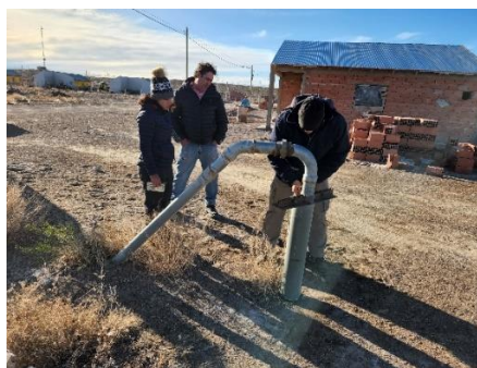
Ilustración 137 - Pozo 1. Medición de niveles
