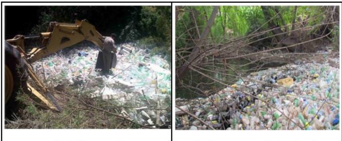
Ilustración 14 - Colector pluvial PII, Cipolletti - Fuente: DPA 2015
