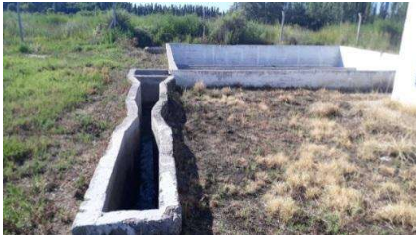
Ilustración 67 Canaleta Parshall
