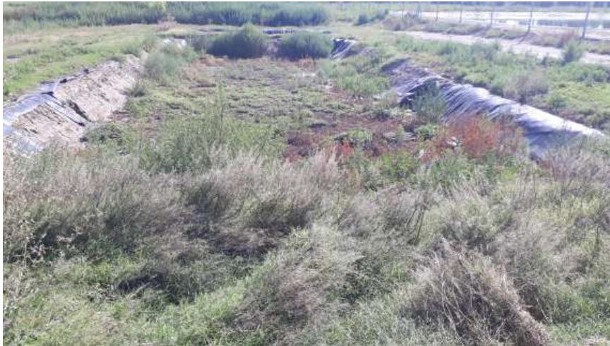
Ilustración 69 Secado de pileta de barro
