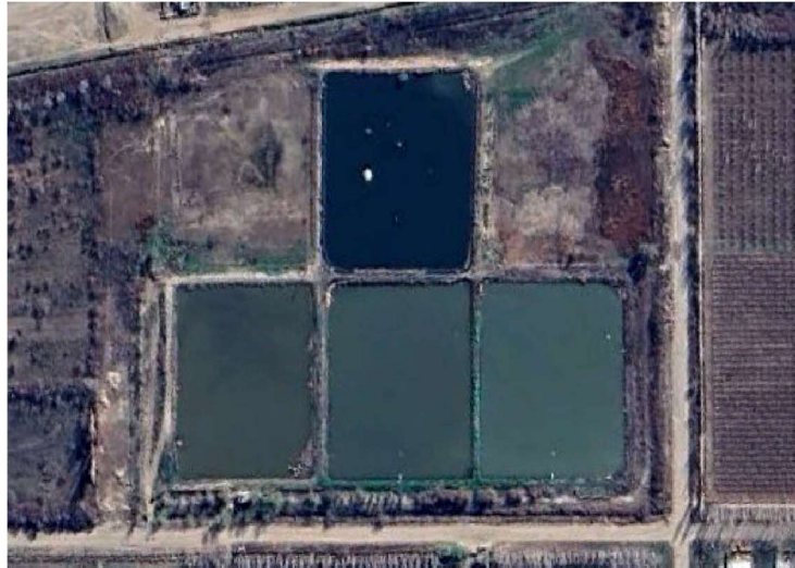
Ilustración 43 Planta de Tratamiento de Líquidos Cloacales Allen. Fuente: ARSA
