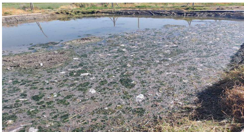
Ilustración 65 Pileta de descarga del camión atmosférico. Fuente: DPA
