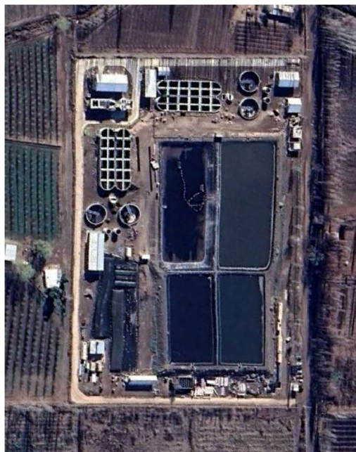
Ilustración 53 Planta de tratamiento cloacal - Cinco Saltos
