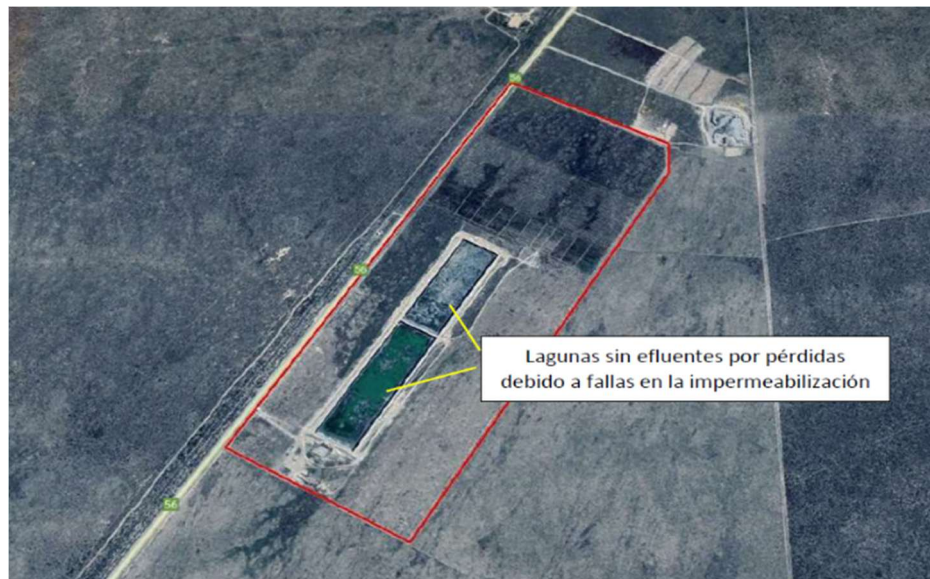
Ilustración Problemas constructivos en lagunas de tratamiento. Fuente DPA
