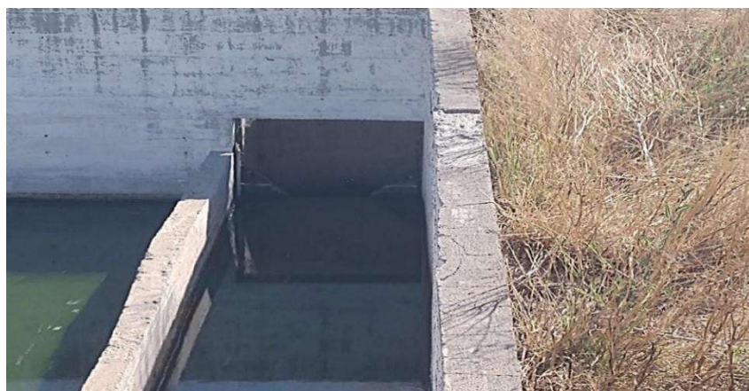
Ilustración 68 Cámara de salida
