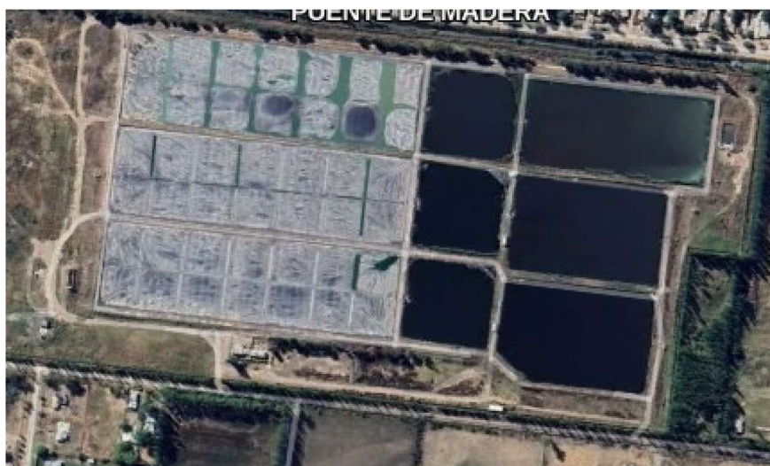
Ilustración 49 Planta de Tratamiento de Líquidos Cloacales Cipolletti. Fuente: ARSA
