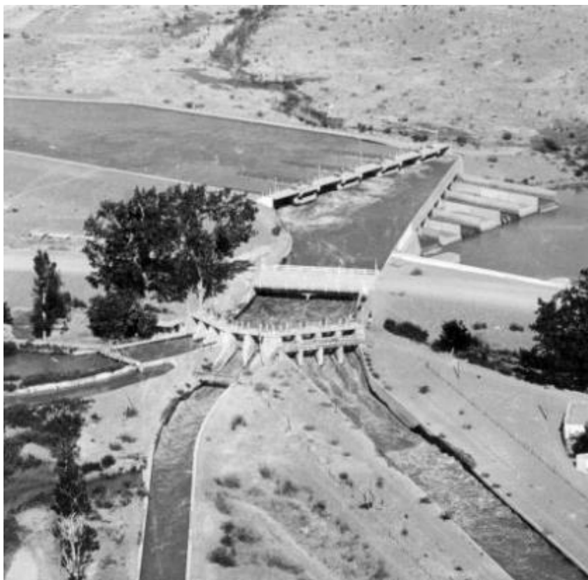
Figura 3-68: Foto Aerea (1960) Camara desarenadora canal Matriz, canal colector y Partidor San Emiliano. San Juan. Archivo PGICH-UNSJ.
