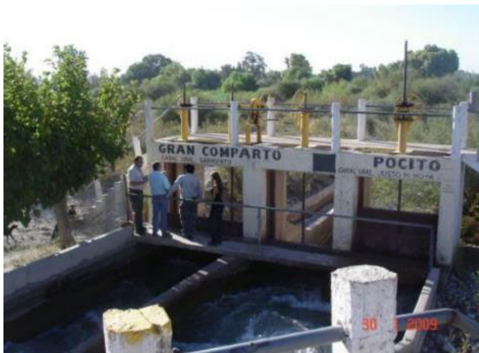
Figura 3-89: Foto Vista del Gran Comparto, obra final del canal Céspedes y donde se divide e inician el canal General Sarmiento con dotación de 21708 has (censo 2017) y el canal Gral Justo Moya con dotación para 8878 has (censo 2017). Gentileza PROSAP
