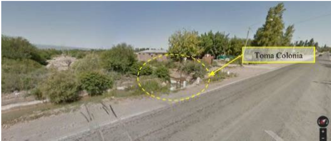
Figura 3-86: Foto Derivador Santa Lucia, dado que el canal atraviesa largos trayectos poblados la basura es un problema a solucionar. Gentileza Google.
