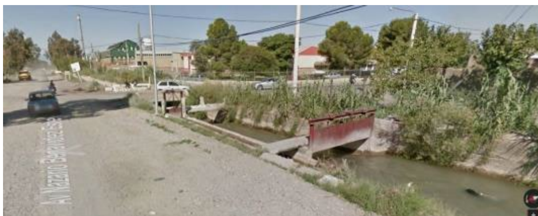
Figura 3-85: Foto Comparto Mogote donde nace el canal General Mogote que riega unas 1537 has. gentileza Google.
