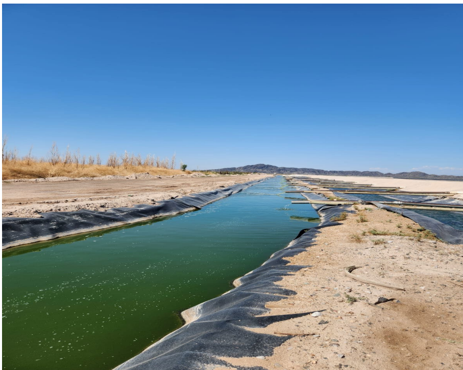
Figura 9-9: Disposición de los efluentes de la planta – concentración de algas en los mismos
