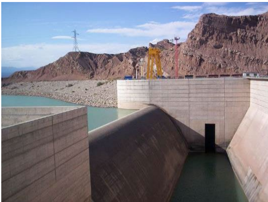
Figura 3-56: Foto del vertedero lateral y de la cubeta del aliviadero del Dique Quebrada de Ullum. (Dölling 2021-PGICH- Proyecto SARH).
