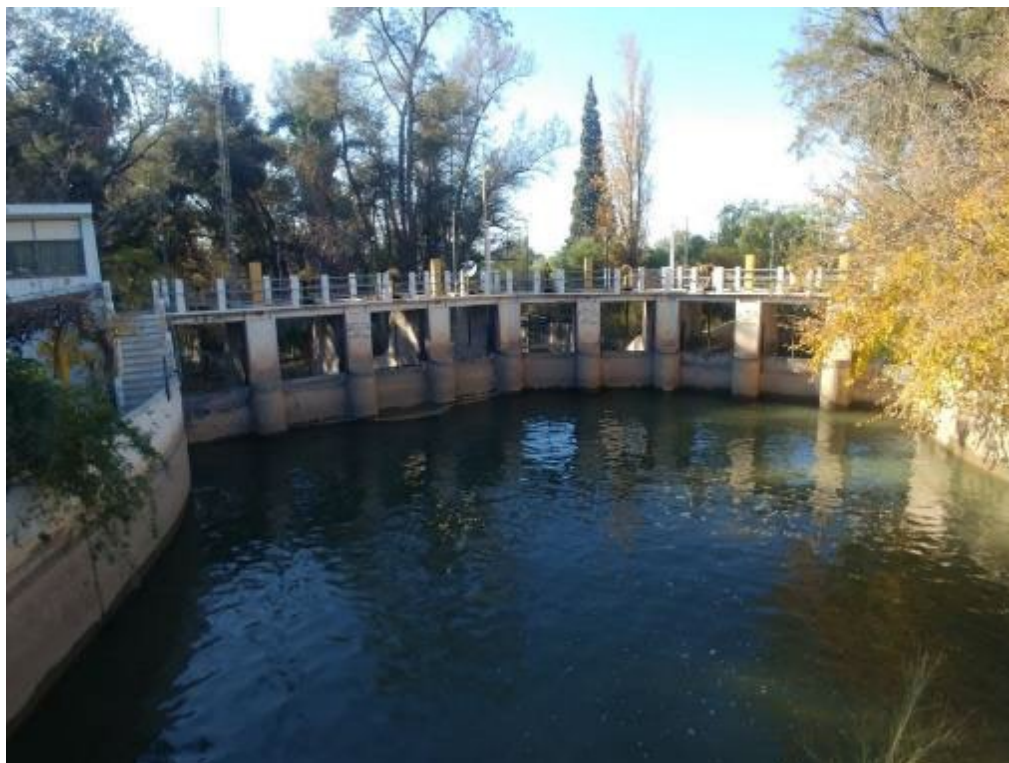
Figura 3-69: Foto frontal Partidor San Emiliano, so observan las 9 compuertas que controlan el ingreso de agua a los 3 canales principales del sistema de riego del Valle del Tulum.
