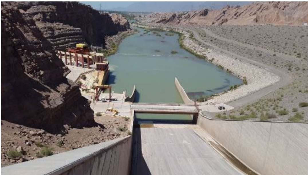
Figura 3-57: Foto de la rapida del aliviadero del Dique Quebrada de Ullum. Manual de usuario sistema SARH- San Juan (Dölling et all 2021- PGICH- Proyecto SARH).
