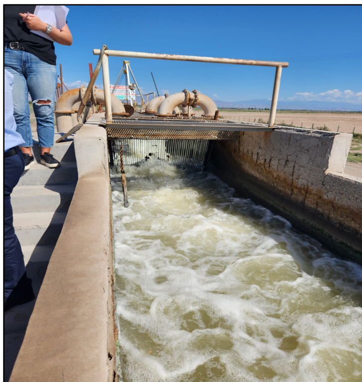
Figura 9-7: Aguas residuales tras haber pasado por 2 rejas en series (10 y 7 cm)
