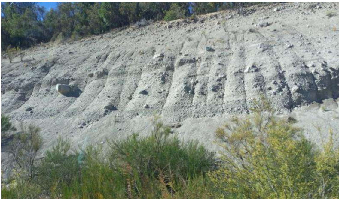
Figura 44. Caídas y conos de deyección. Margen izquierda de la Ruta Nacional Nº 40, entre Bariloche y El Bolsón.
