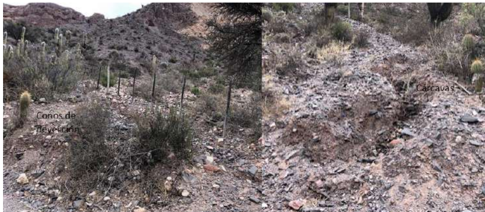
Figura 76. Conos de deyección y cárcavas en Bodega “Huichaira”.
