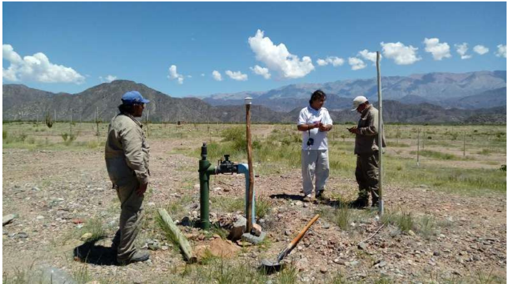
Figura 6. Operativo de Instalación y breve capacitación al personal de la empresa.
