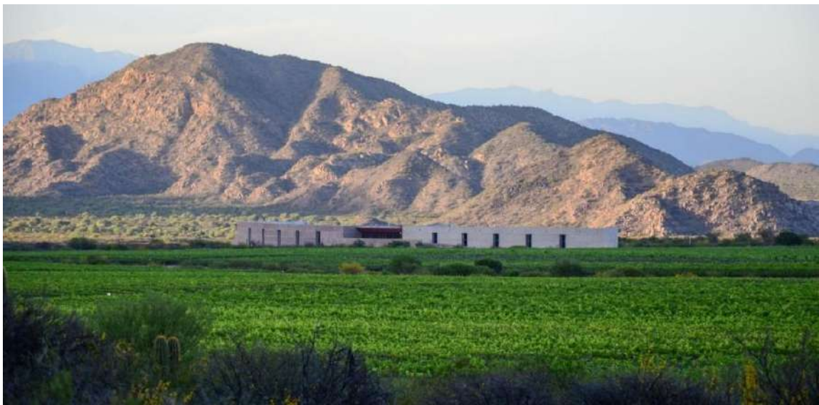
Imagen 11. Chañarmuyo. Nuevos emprendimientos descubren lugares. Arquitectura moderna, simple, respetuosa, con colores que se mimetizan con el lugar. Lo plano del viñedo se repite en lo plano de la construcción. Fotografía: Diego Díaz.
